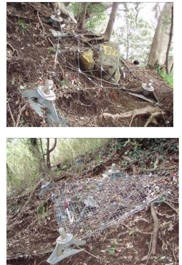
図-5：ノンフレームネットの施工結果
