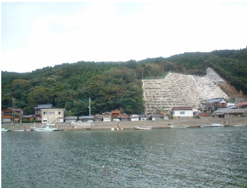
施工後比較 左側:ノンフレーム工法、右側:従来技術
