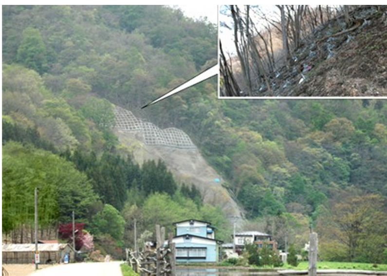
施工事例 拡大崩壊防止として採用
