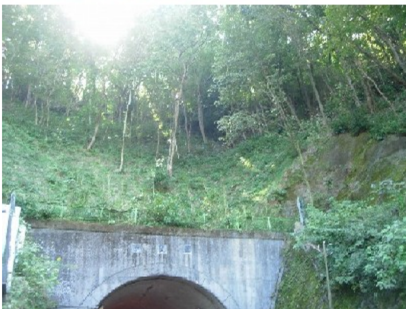
施工事例 上:斜面内状況 下:斜面全景
