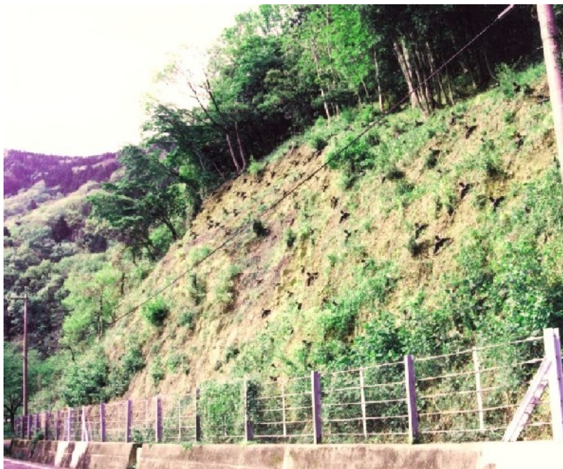
施工事例 道路法面での採用(めっき後塗装品使用)
