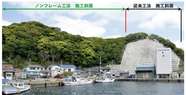
ノンフレーム工法で施工した斜面は、自然も守られています。
