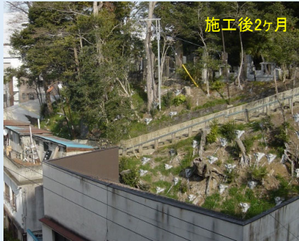
狭小な施工ヤードで施工
