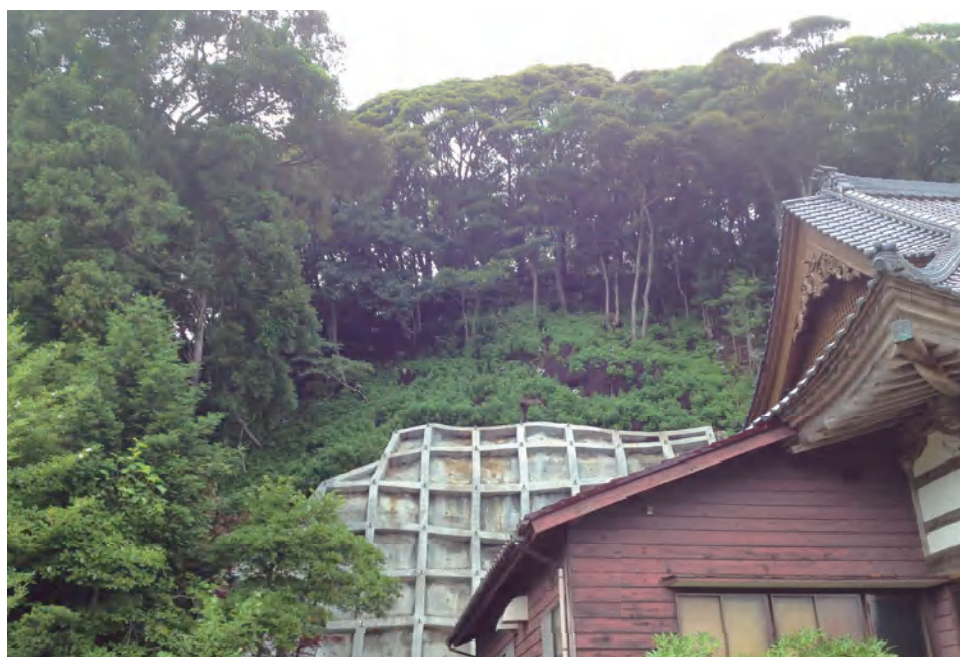
施工後 4 ヶ月の状況。斜面上部、ノンフレーム工法施工範囲は元々の景観が保たれています。
