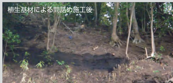
空洞化した箇所は植生基材で間詰めしてから、ノンフレーム工法を施工しました。
