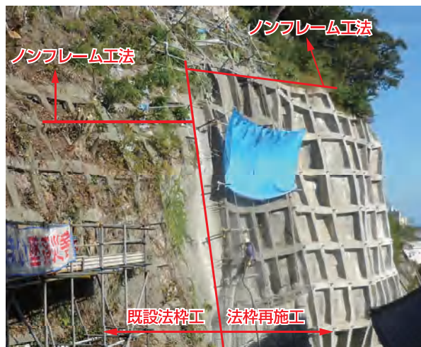
対策工事 施工状況
