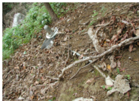
写真-2 斜面内状況
