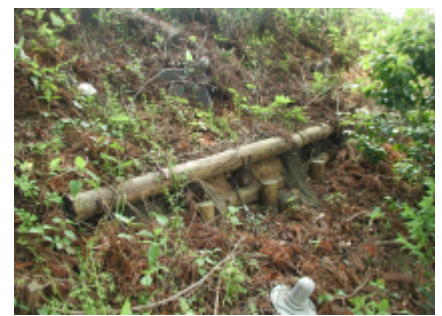
写真-6 斜面内状況
