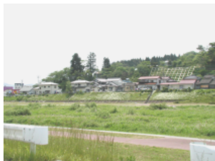
写真-3 大船渡地区斜面全景
