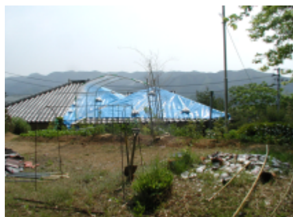
写真-5 ノンフレーム施工箇所付近民家
